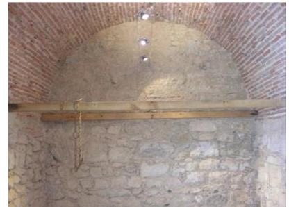
Fig. 3 - Partie production : voûte en brique d'une des deux étuves.
