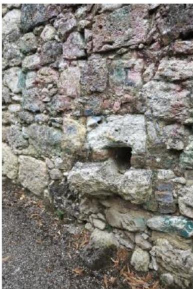
Fig. 8 - Mur de clôture ouest (bouche d'évacuation dans le carrelot).
